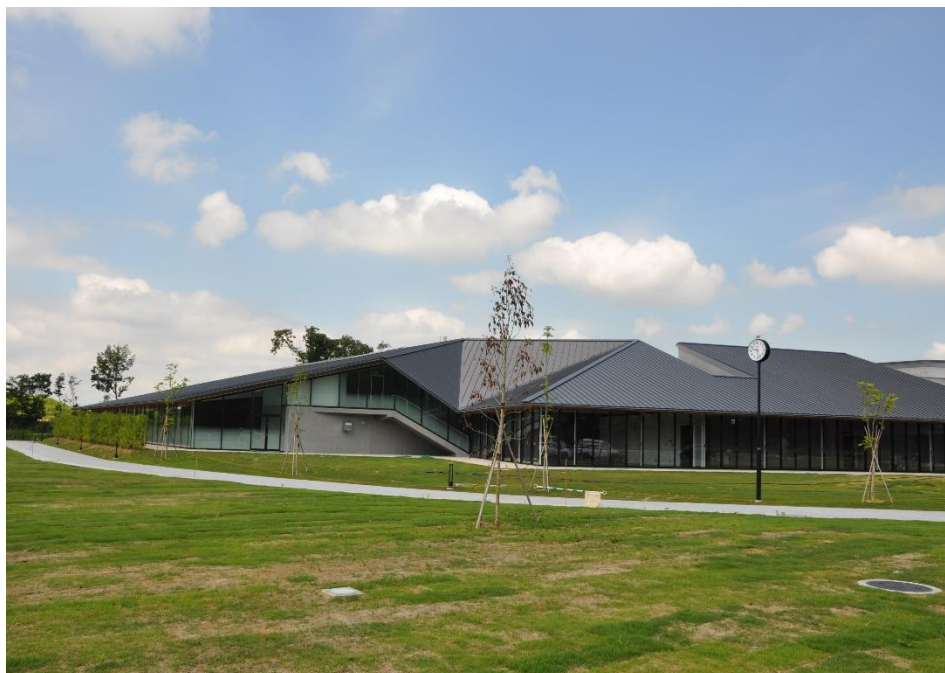
健康増進等施設建設機械設備(給排水)工事
